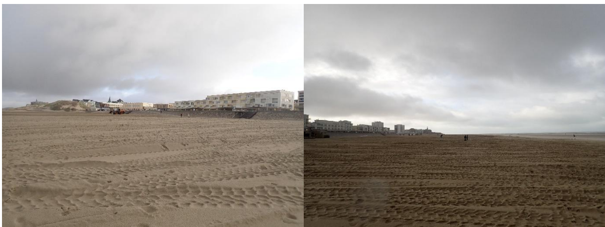
Figure 33 : Tracteur remodelant la zone (à gauche) et emprise de la zone criblée (à droite) le 22 octobre 2024
